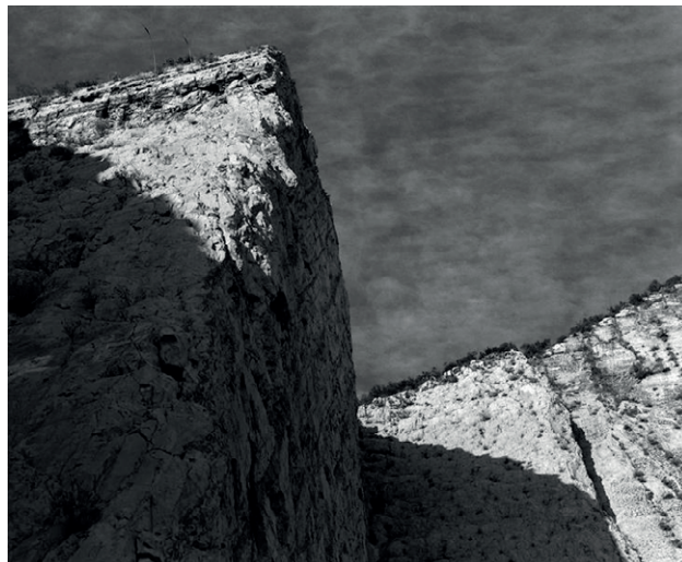
Fig. 1. Vista angular de la pared de una pedrera en el cerro de Las Mitras, en donde ha habido deslaves y derrumbes por lluvias. Esta imagen muestra el rompimiento de la montaña ya que en la parte superior se puede apreciar todavía la capa vegetal, la cual se tiene que desmontar antes de comenzar la voladura. Es prácticamente imposible reforestar las pedreras por la gravedad de la erosión al momento de barrenarlas para colocar los explosivos y producir la fractura o corte de la roca. Oswaldo Ruíz, 2020, Monterrey, Nuevo León, México.
