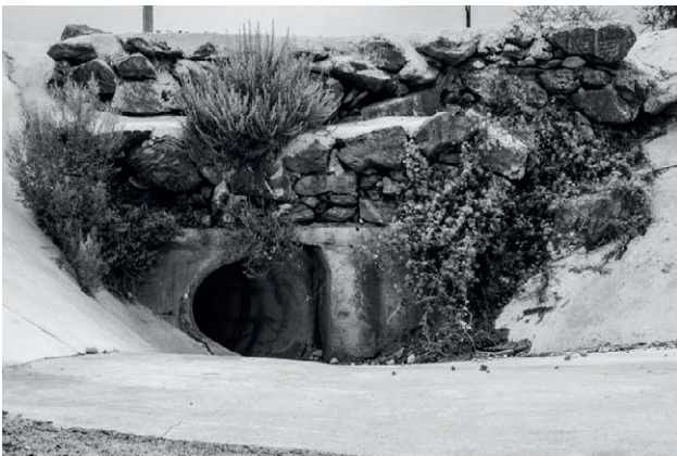
Fig. 6. Otra vista de la misma infraestructura de concreto para la salida del agua. En ella se puede apreciar la superposición de rocas previas a su transformación en cemento y el resultado del proceso ya en placas y tubos de concreto. Oswaldo Ruíz, 2021, Santa Catarina, Nuevo León, México.
