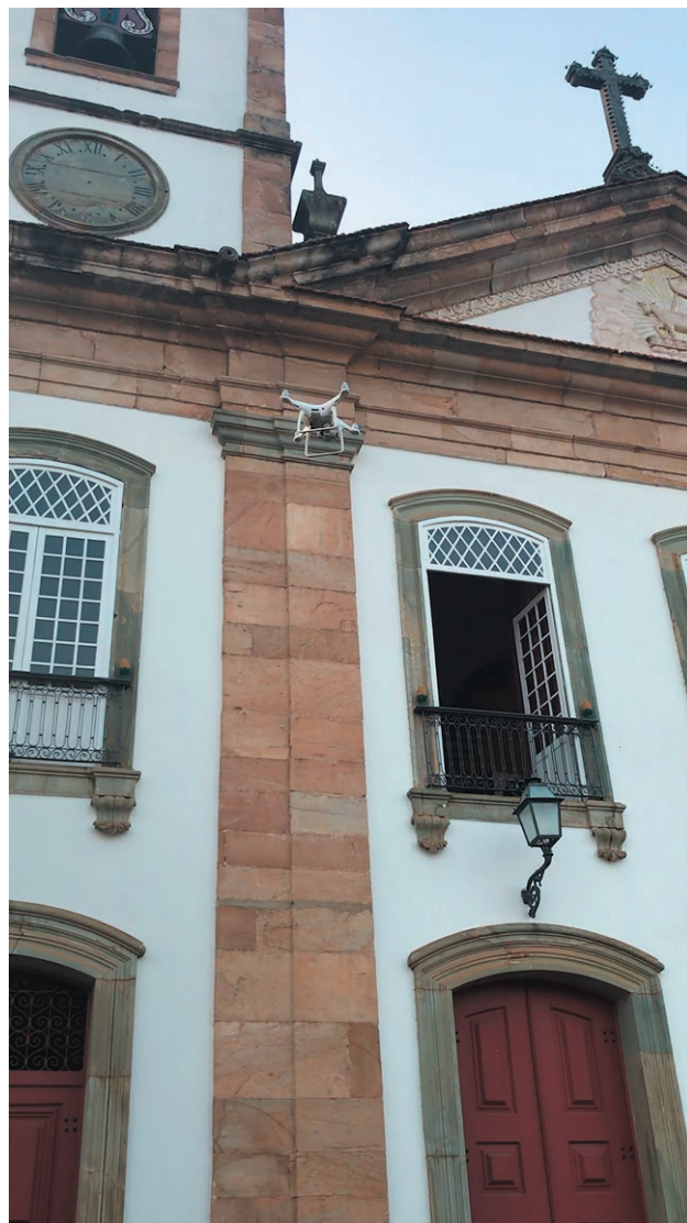
Fig. 4. Brasileiro, Vanessa, Luiza Salles Araújo, André Dangelo. Voo de drone ao redor da Igreja Matriz do Pilar de São João del Rei. São João del Rei. 2020. Acervo pessoal.
