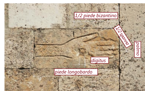
13,14,15 | Chiesa di S. Maria Assunta a Bominaco (XII-XIII sec.). Vista della facciata e del fronte destro. Particolare di un concio con il disegno di un braccio con mano ed indicazione di come le dimensioni fungano da riferimento metrico.
