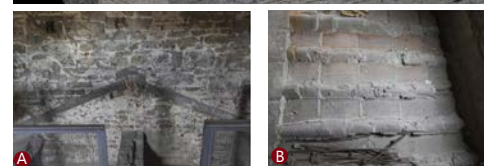
10 | Elaborazioni dei rilievi tridimensionali che mostrano, in questo caso specifico, le tracce ancora visibili di precedenti sistemi di copertura della Sagrestia Vecchia, che ci obbligano a riflettere sulla precedente configurazione dei volumi oggi visibili e sul progetto originario di Filippo Brunelleschi.
